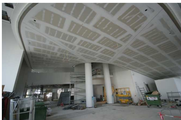
Het plafond onder de hellingbaan vóór de eindafwerking
