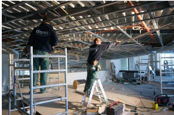
Het plafond onder de hellingbaan tijdens de montagefase
